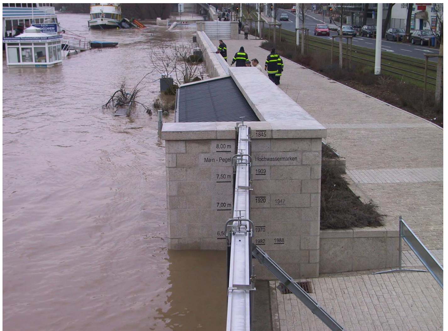
Hochwasser Januar 2003: Höchststand Pegel Würzburg 6,48 m | 350 m 3 /s | ein ca. 20-jähriger Abfluss. Der Abfluss des Hochwassers vom Juli 1342 von 3300 m 3 /s +/- 10% hat zwischen 9,5 und 10,3 m erreicht! Das Hochwasser von 1784 mit 2600 m 3 /s würde etwa 9,2 m erreichen
